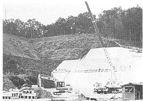
写真-8 美東での斜面Ⅰの復旧対策工
