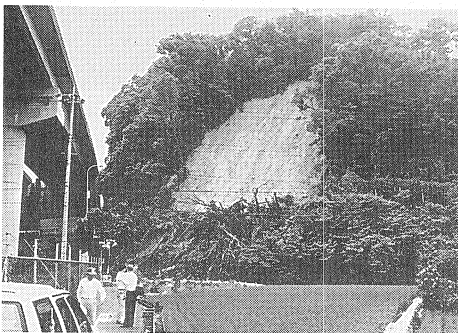
写真－9 徳山での斜面Ⅰの崩壊状況
