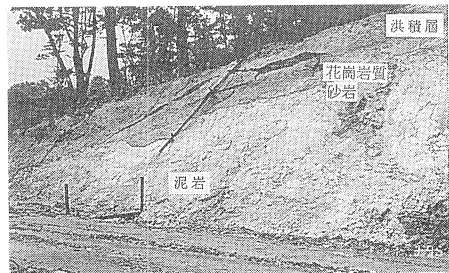
写真-4(a) 豪雨による崩壊開始時(1995年7月2日)の切土斜面(②-2)の状況
