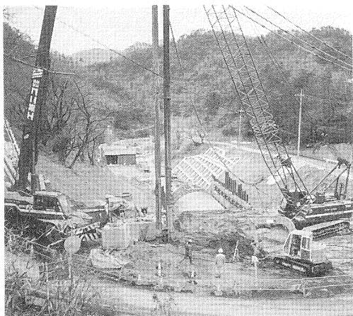
写真-5 抑止杭施工状況
