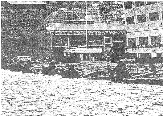
写真-1 函館港第6岸壁被災写真
