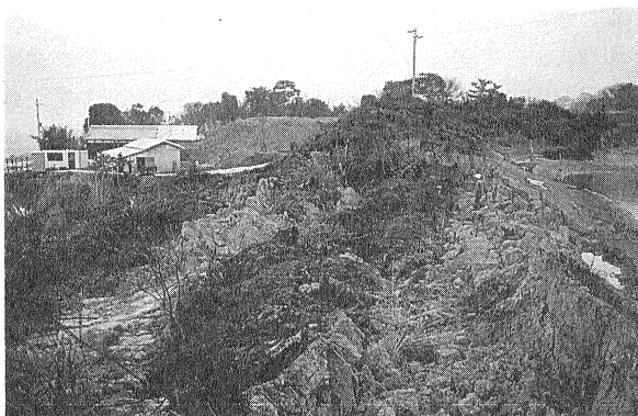
写真-1 井手の尻池決壊状況
