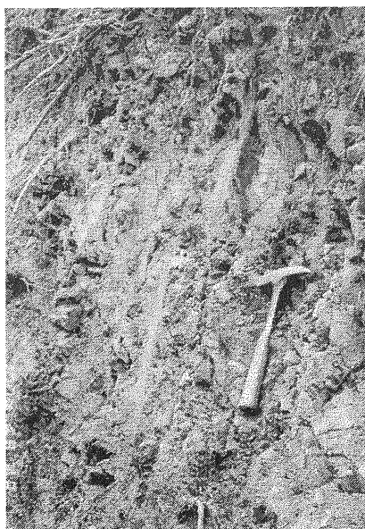
写真-2 砂岩斜面節理面上の黒色土（山口）
