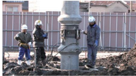
写真-6 機械式継手取付状況
