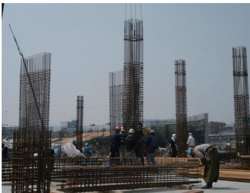
写真-9 鉄筋先組状況
