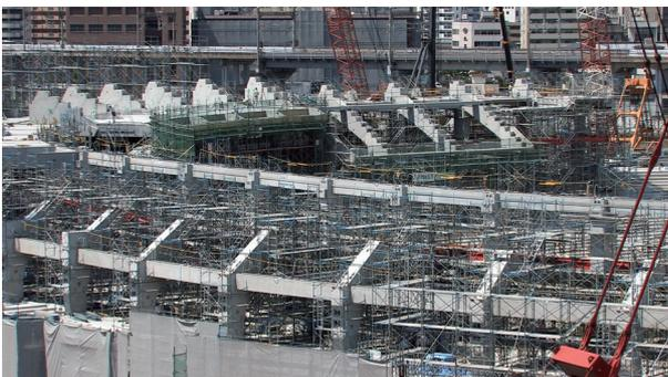
写真-12 プレキャスト部施工状況
