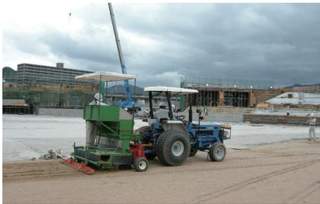
写真-14 専用撒き芝機による植え付け
