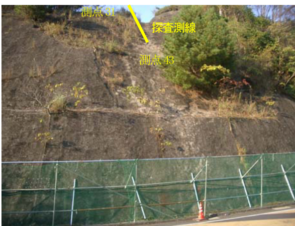
写真-2 探査測線 (測点42側)
