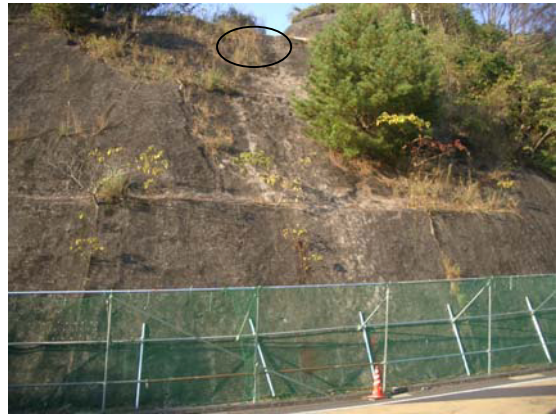
写真-6 法面内でプラス値を示す位置
