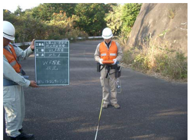
写真-5 探査状況
