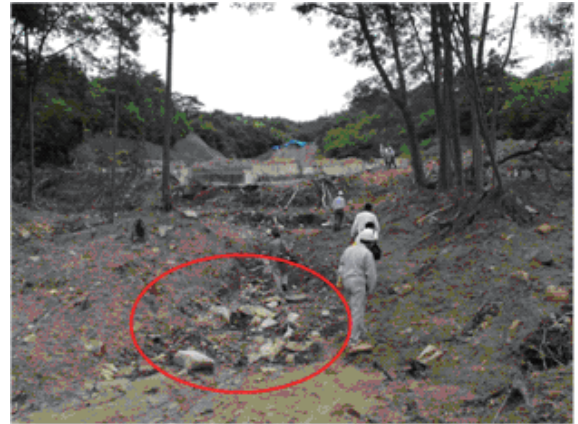
写真-2 崩壊斜面下流の溪床堆積物層(8/7 撮影)
