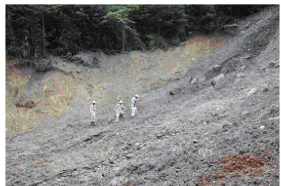
写真-3 崩壊地右岸の状況(8/7 撮影)
