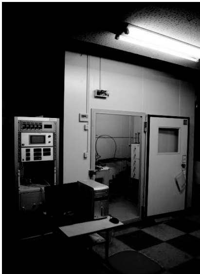
写真-1 冷蔵室の外観
