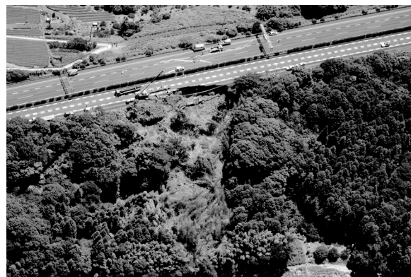
写真-1 東名高速道路における盛土の崩落状況 (撮影：国際航業(株)/(株)パスコ) [写真上側が南]
