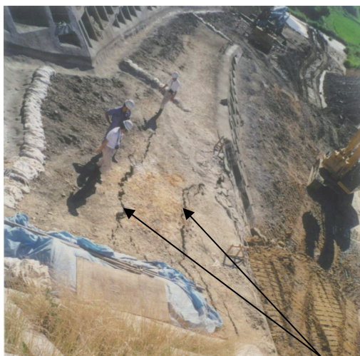
写真-6 広域農道後背部の側道に発生するクラック： 最大開口幅 5cm 程度
