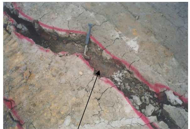
写真-9 クラックの最大開口幅 1cm 程度
