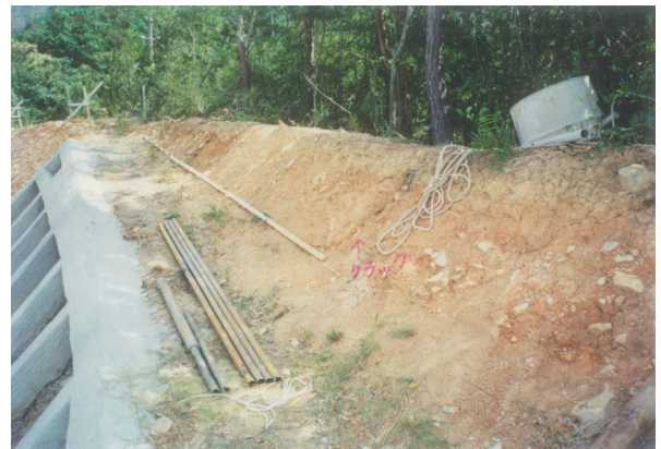
写真-8 写真-7の一部の接写：断層面に沿って発生した クラックの最大開口幅 10cm 程度 (断層面の走向・傾斜：N74°W・30°N)
