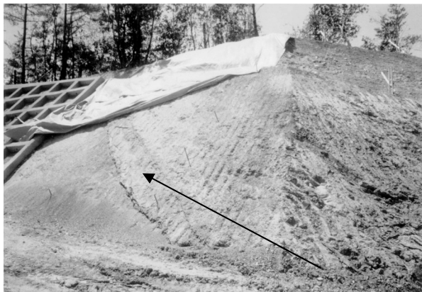
写真-11 C法面の切土時に発生した表層すべり (写真位置は図-3に示す)
