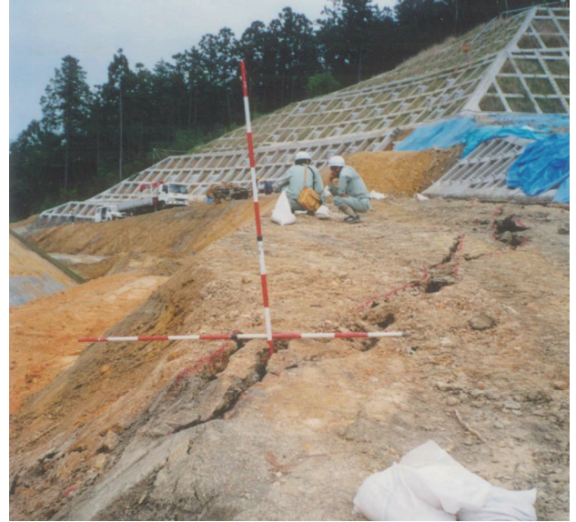
写真-7 B法面の切残し部No.507～No.509+10付近に及ぶ クラック：最大開口幅 10cm 程度
