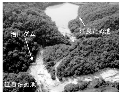
写真-14 江良ため池周辺の航空写真
