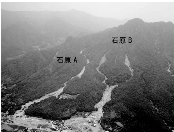
(a) 石原地区での土石流(山口県提供)
