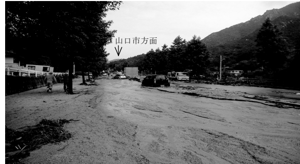
写真-1 国道262号の被災状況
