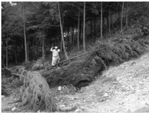
写真-6 崩壊下部の様子（右岸側）
