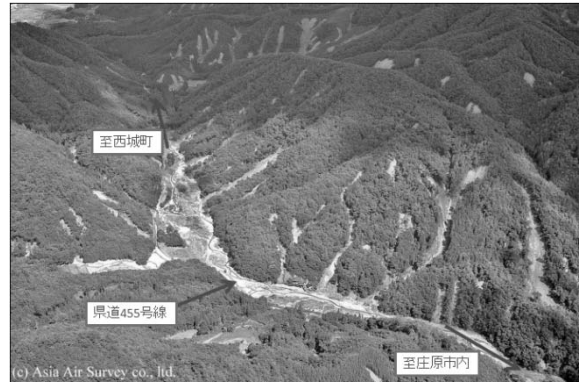
写真-1 篠堂地域の斜面崩壊の状況
