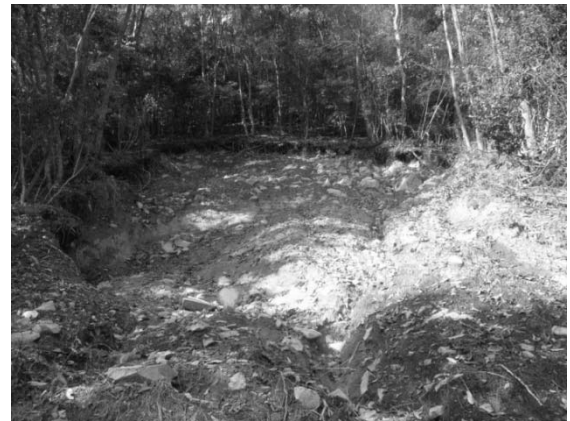
写真-3 平行斜面中腹の崩壊 2
