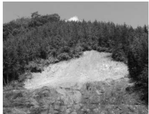
写真-7 詳細に調査を行った平行斜面の崩壊（写真-2の拡大図）
