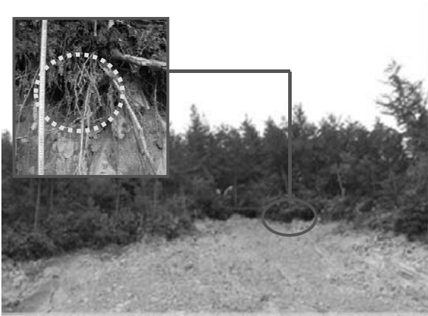
写真-5 崩壊上部の様子
