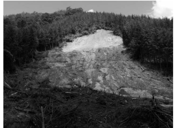
写真-2 平行斜面中腹の崩壊 1
