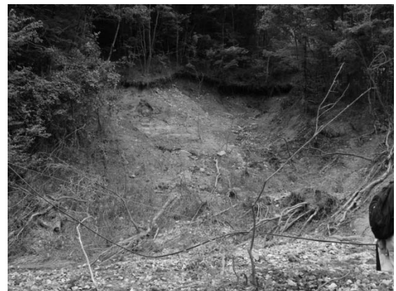
写真-4 平行斜面中腹の崩壊 3
