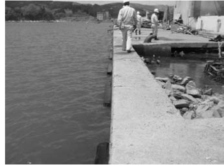
写真-33 岸壁と調査時の海面の状況
