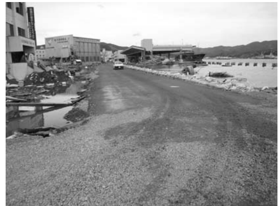
写真-40 仮設道路設置状況
