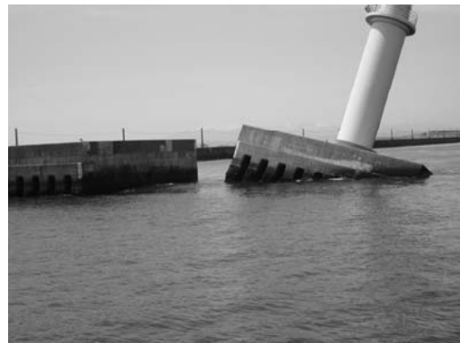
写真-12 C防波堤堤頭部の被災状況（図-8①）
