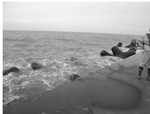
写真-29 南防波堤消波ブロック沈下状況（図-14写真①）
