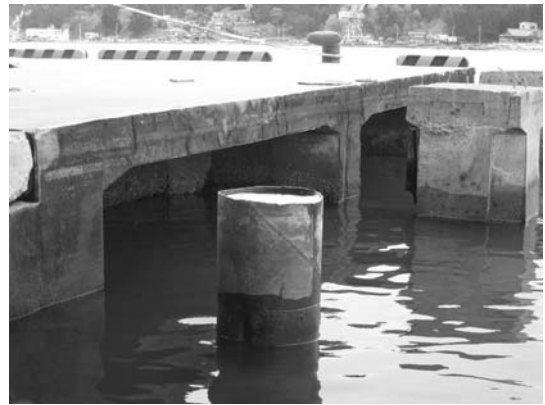
写真-38 棧橋上部工の消失その 1 (図-19①)
