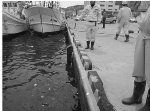
写真-49 野々田地区岸壁の海水面からの高さ
