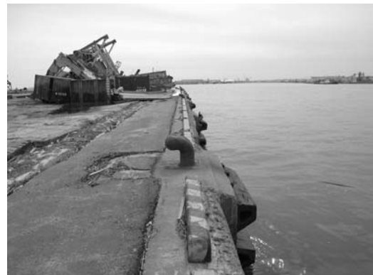
写真-21 南浜埠頭岸壁法線状況（図-12②）
