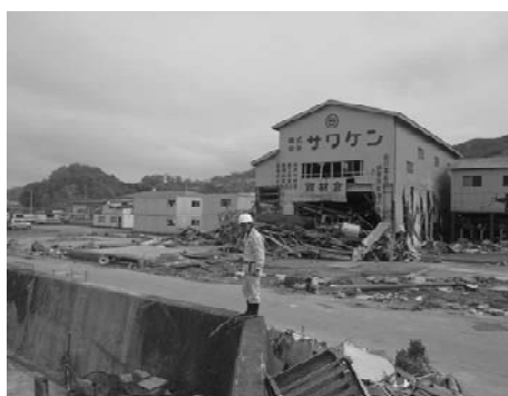
写真-53 港と市街地との境界にある防潮堤
