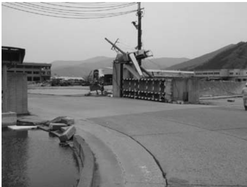
写真-47 茶屋前-9m 岸壁入り口のひ門の状況
