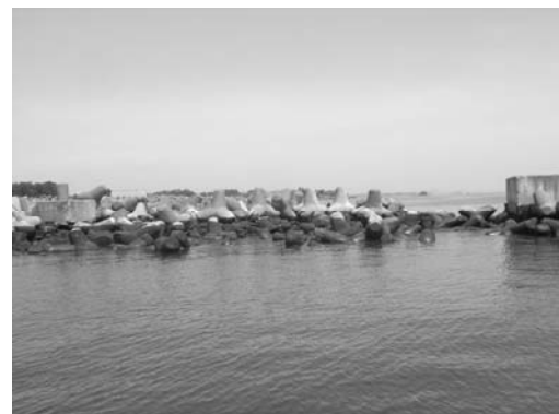
写真-14 北防波堤（傾斜堤部）の被災状況（図-8③）
