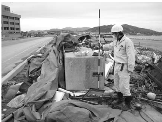
写真-43 防潮扉被災状況 (図-20②)
