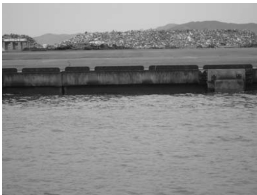
写真-19 雲雀野埠頭岸壁前面状況（図-10⑤）
