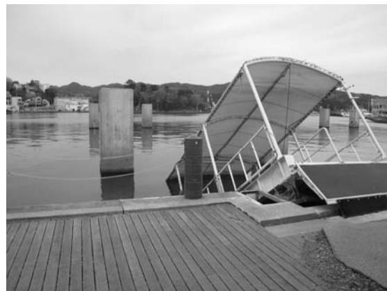
写真-44 浮き桟橋渡橋落下状況 (図-21①)
