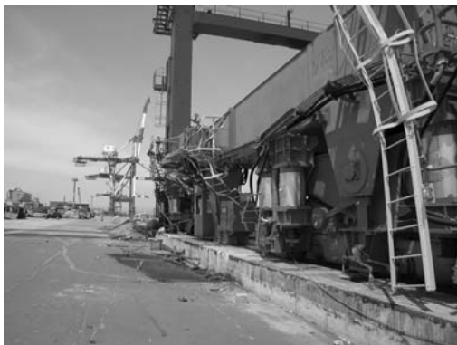
写真-7 クレーン状況 (図-6 写真⑦)
