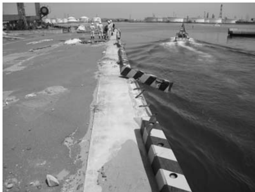
写真-3 車止めの損傷（図-6③）
