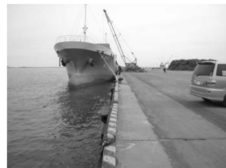
写真-27 中島埠頭岸壁法線及び瓦礫荷役状況 (図-13④)
