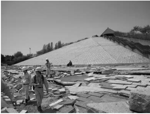
写真-8 石張りブロックの散乱状況（図-7①）
