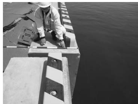
写真-1 一部法線の出入り（図-6①）
