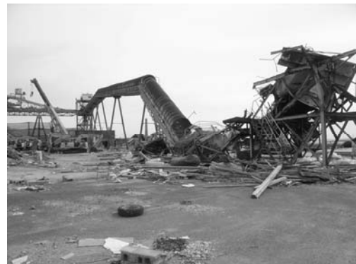
写真-20 南浜埠頭チップ荷揚げ設備被災状況（図-12①）
