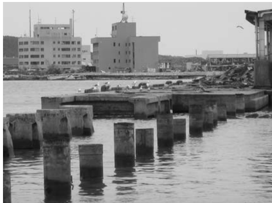
写真-39 棧橋上部工の消失その 2 (図-19①)
