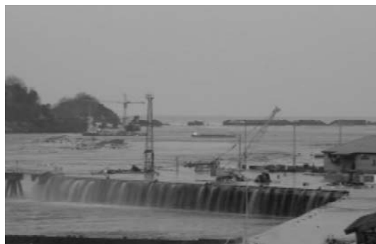
(b) 引き波第1波の状況
