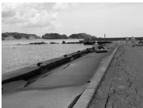
写真-36 岸壁の状況
