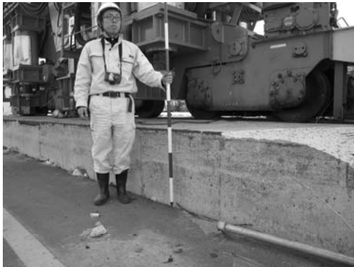
写真-5 クレーン基礎と地盤の段差 (図-6⑤)
