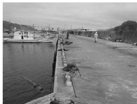
写真-52 釜石港の観光船はまゆりが接岸する港奥の岸壁右から沖合方向
