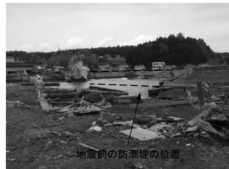
写真-34 伊里前川左岸側の防潮堤跡
