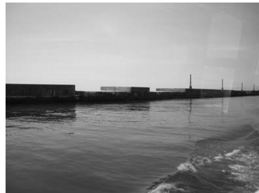
写真-13 南防波堤上部工の被災状況（図-8②）
