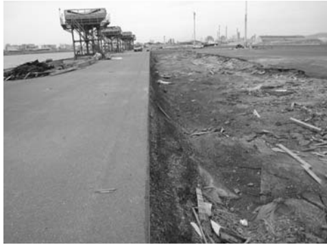
写真-16 雲雀野埠頭背後地盤の段差状況（図-10②）
