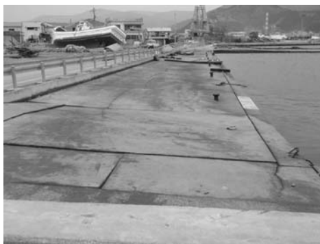
写真-48 野々田地区岸壁の状況
