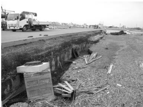
写真-18 雲雀野埠頭段差部ケーソン露出状況（図-10④）
