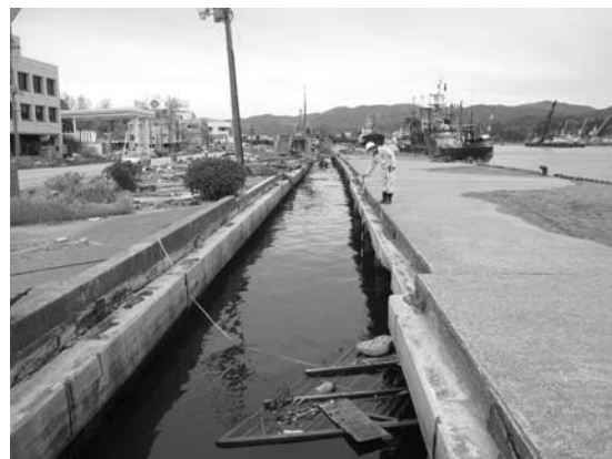
写真-41 渡版落下状況と棧橋本体の変形 (図-19③)
