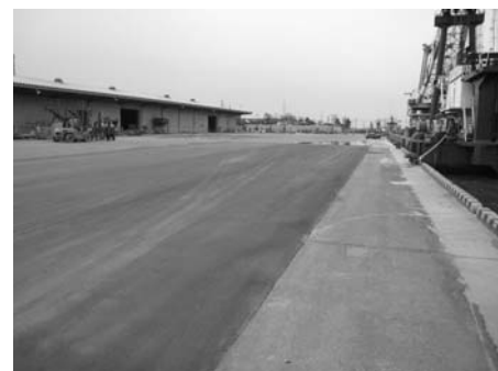
写真-28 中島埠頭背後地盤復旧状況 (図-13⑤)
