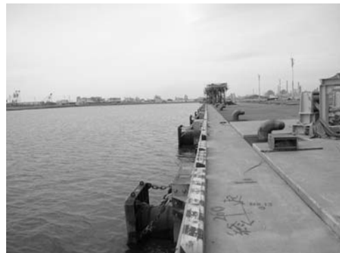
写真-15 雲雀野埠頭岸壁法線状況(図-10①)
