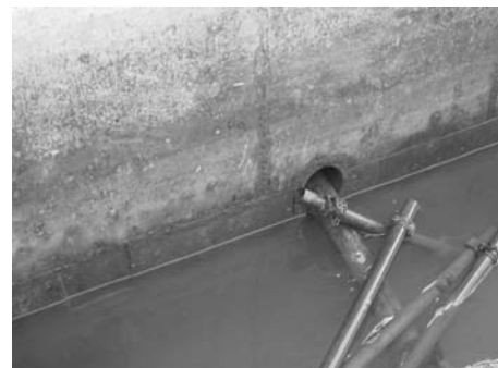
写真-2 タイ材の露出状況（図-6②）
