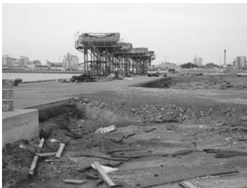
写真-17 雲雀野埠頭応急復旧状況（図-10③）
