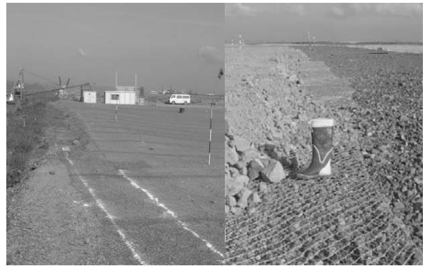
写真-1 敷金網敷設状況
