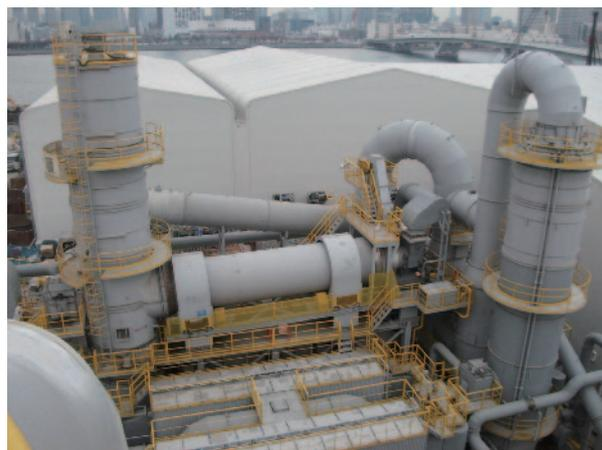
写真-1 本研究で開発した油汚染土壌浄化システム
