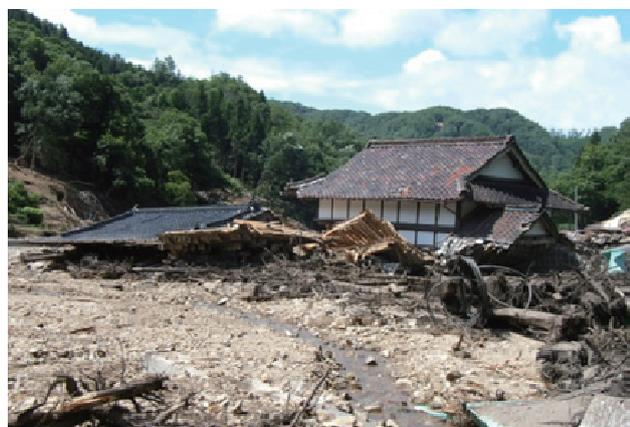
写真-5 篠堂川右岸で発生した土石流による家屋の被害（広島県提供）
