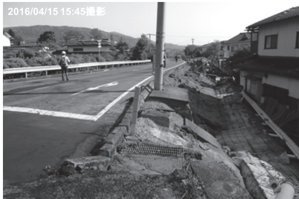
写真-2 道路盛土の被災状況(益城町寺迫交差点南側) 1)
