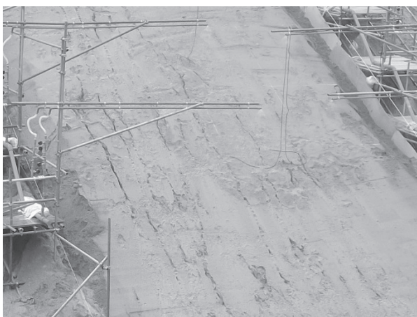
写真-2 ガリー侵食発生状況
