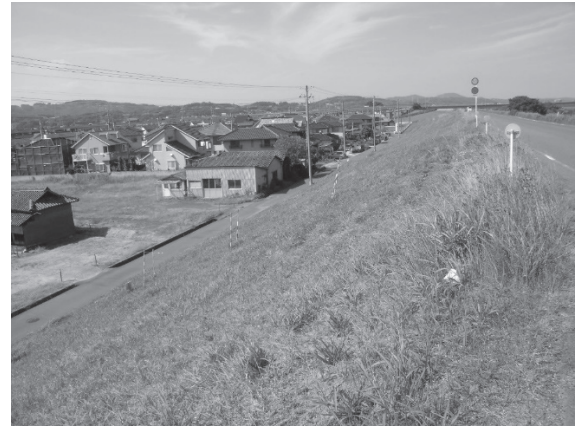
図-6 解析対象地点の河川堤防斜面の状況
