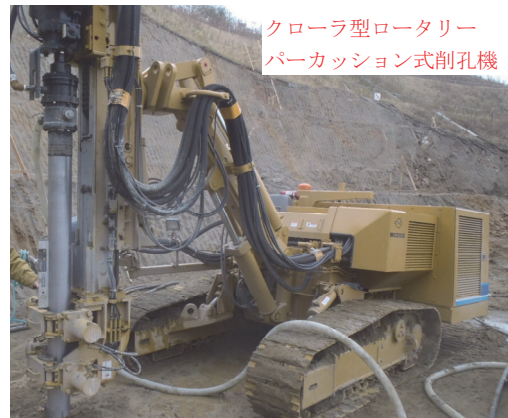
写真-1 アンカー削孔機据付状況
