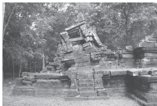
図-1 崩落した構造物(西トップ寺院) 5)
