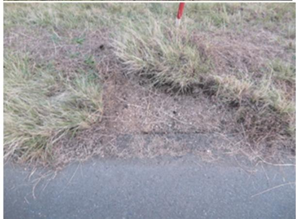
図-12 計測対象区間に存在する法崩れ
