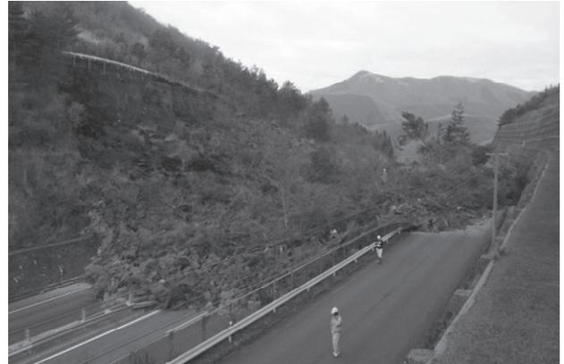
写真-1 切土斜面の崩壊状況 (西日本高速道路(株)提供)
