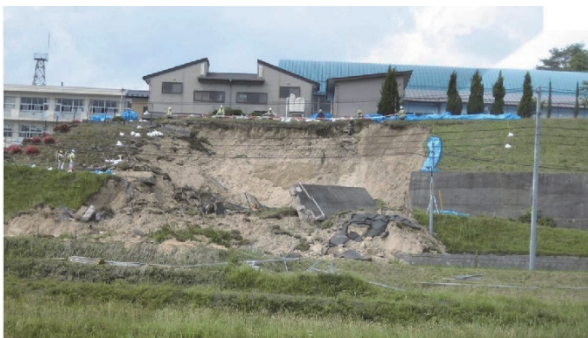
写真-1 コンクリート擁壁の崩壊 1)
