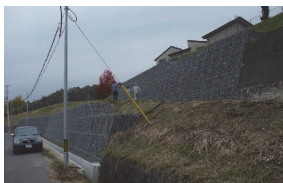
写真-2 フトンカゴ擁壁による復旧 1)
