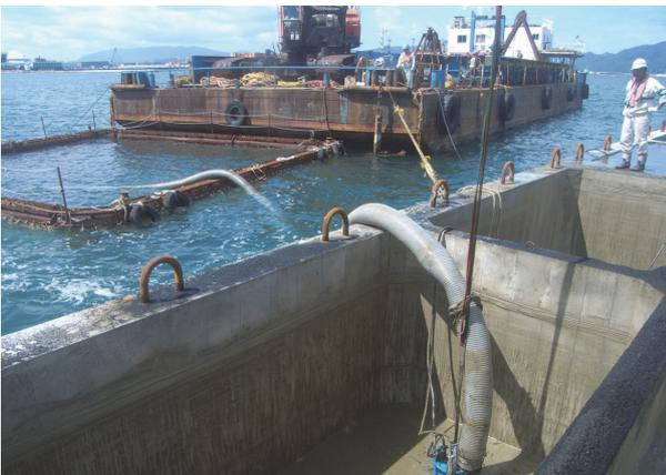
写真-8 ケーソン隔室内排水状況
