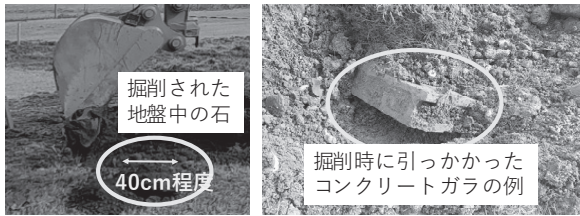
図-16 異常値の原因となるコンクリートガラの例
