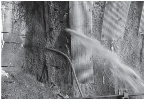
写真-6 水抜きボーリング時の湧水状況 (380m 付近)
