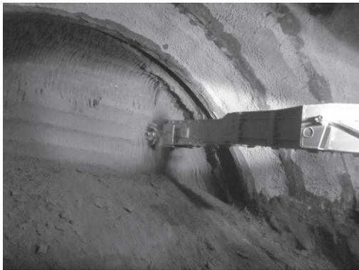
写真-1 掘削状況（固結度が高い）
