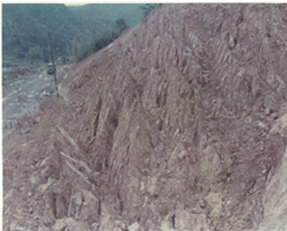
写真-1 ノコギリ状の崩壊 (1972年5月撮影)
