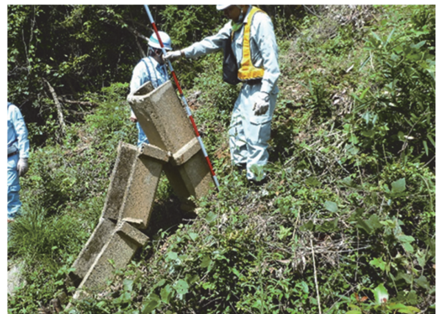
写真-3 たて溝水路の変状 (2014年8月撮影)
