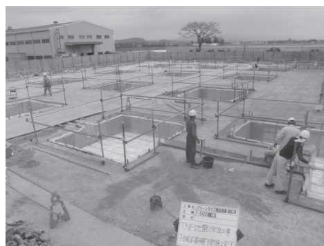
写真-7 ソイルバッグの敷設完了検査
