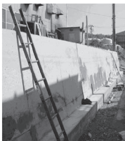
写真-6 表面保護工程
