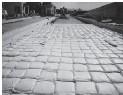
写真-4 路盤施工
