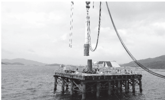
写真-2 試験杭打設箇所の様子 (ハンマーは IHC-S500)
