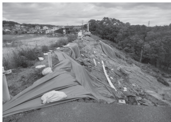
写真-1 下流法面が崩壊したため池 (岡山県岡山市)
