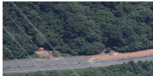
写真-1 平成30年7月豪雨での小規模渓流の崩壊状況
