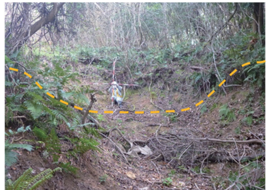
写真-3 崩壊した小規模溪流の現地調査箇所
