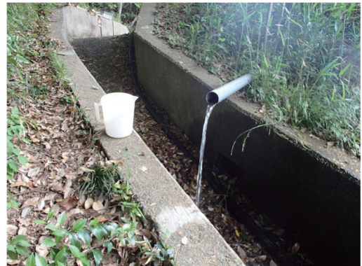
図-8 漏水量調査状況 2019.5.20 (島根県 7) )
