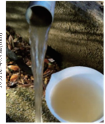
図-14 漏水濁り (10月9日)
