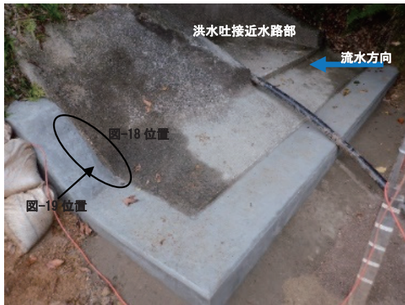
図-20 管理者による洪水吐補修工
