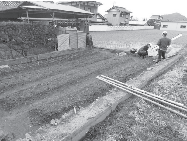
写真-1 富海地区の調査前の現地状況（北東より）
