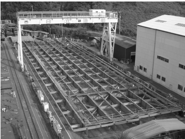
写真-11 北桁仮組立て状況
