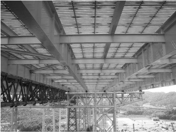
写真-6 下部工構造（頂部水平梁）
