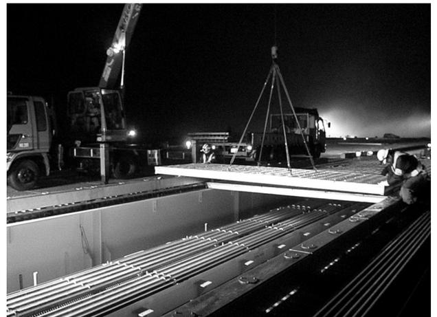
写真-13 上部工（グレーチング）架設状況
