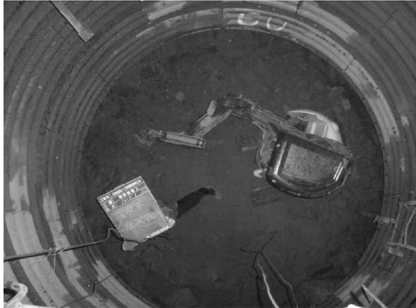
写真-9 基礎掘削状況
