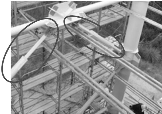
写真-7 ダンパーブレース設置状況
