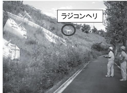
写真-5 ラジコンヘリによるアンカーの撮影状況
