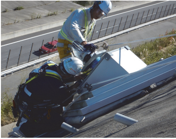
図-14 ロープ高所作業による再生状況
