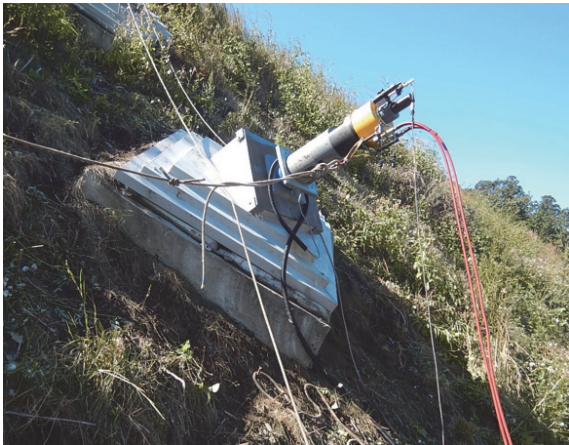
図-15 リフトオフ試験による検証状況
