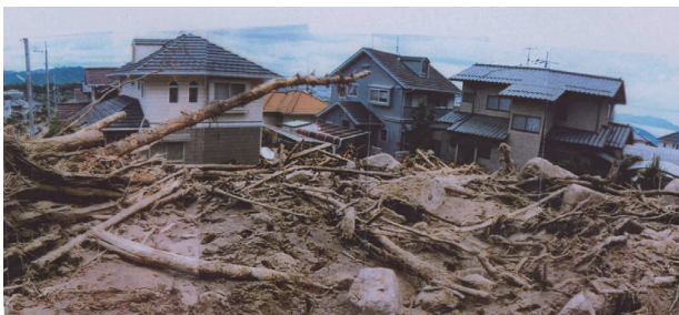
写真-3 平成 11 年 6 月 29 日の豪雨土砂災害の一例 ニュータウンに土砂が入り込み被害を発生させている。 (1999 年 6 月 30 日海堀撮影)
